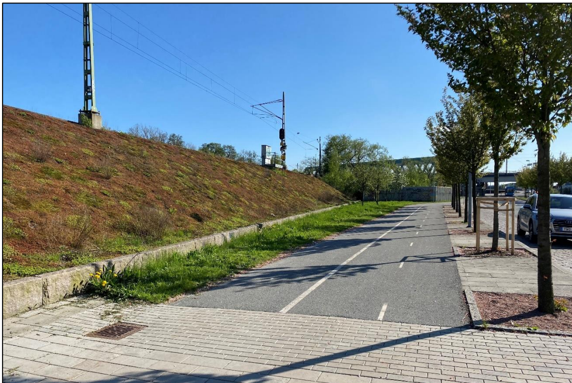
Figur 3. Slänt mot järnvägen, strax norr om föreslaget högvattenskydd. Bildkälla: Niras
