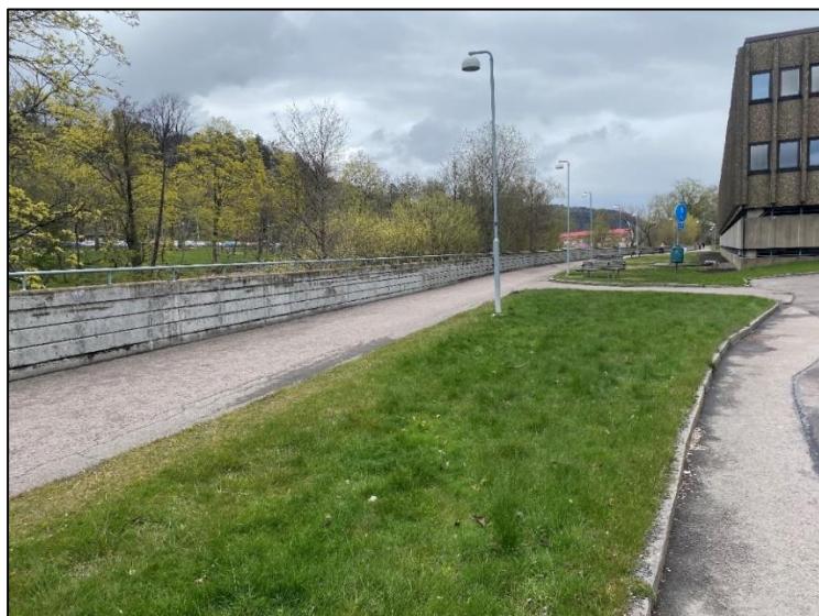
Figur 7. Högvattenskydd längs Säveån i Partille, kommunhuset ses till höger i bilden. Bildkälla: Niras.
