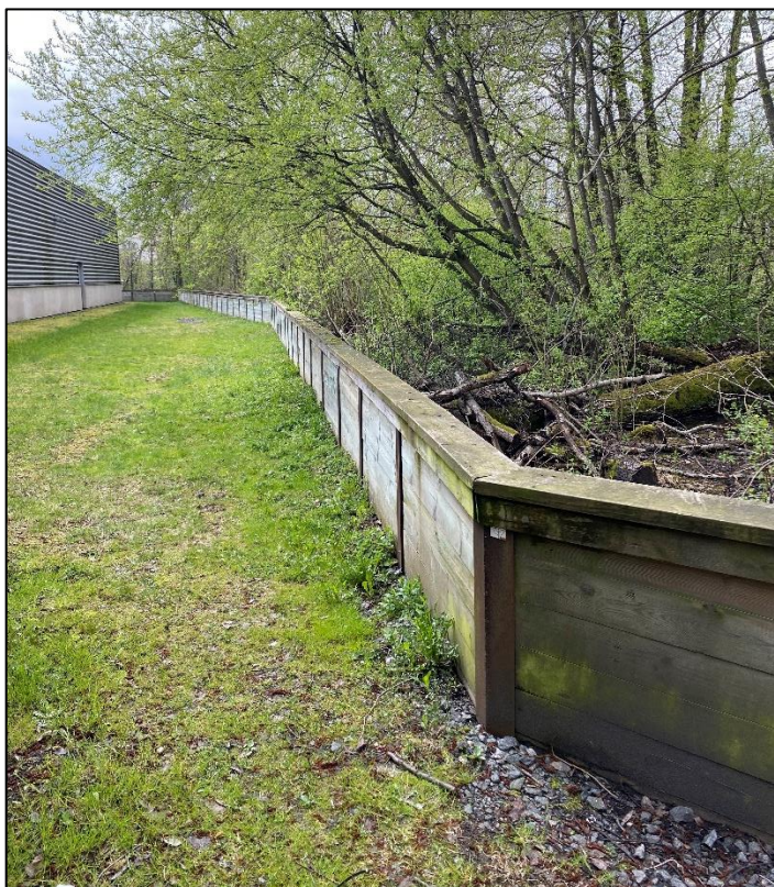
Figur 8. Högvattenskydd längs Säveån i Partille, strax söder om kommunhuset. Bildkälla: Niras
